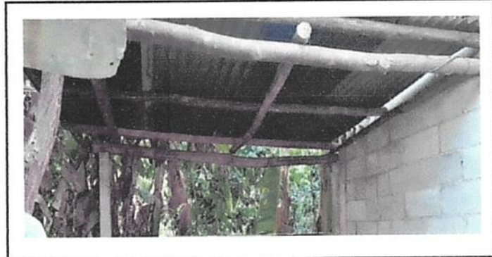
Foto 6: Sustitución de madera por estructura de metal, costanera tipo C de 2X3" con tubo de 4X2" y lamina troquelada calibre 26, en área de cocina.
