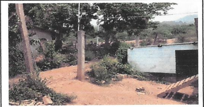
Foto 2: Suministro y colocación de portón de maya galvanizada con tubo de 1 1/2", 3 mts de ancho por 2 mts de alto.
