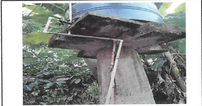
Foto 4: Suministro de rotoplas con sus respectivos accesorios e instalación de tubería PVC de 1/2" a los baños.
